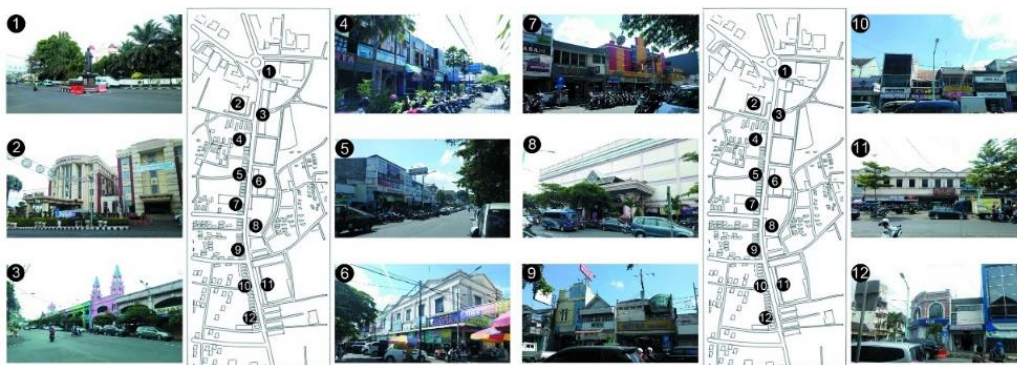
Gambar 2 Kondisi Eksisting Koridor Jalan Jenderal Sudirman Salatiga
