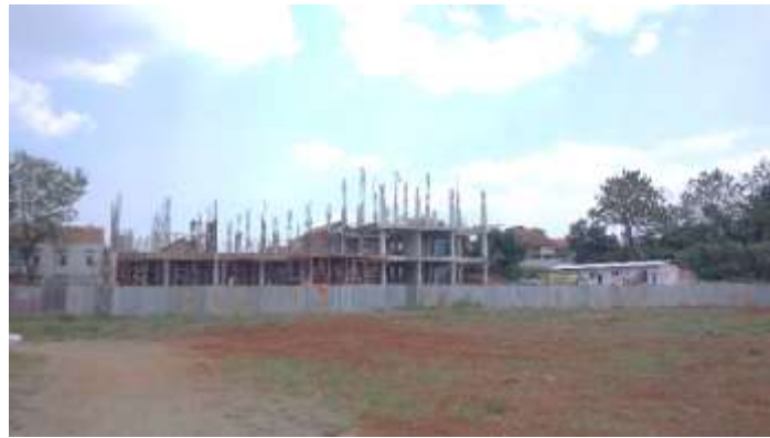
Gambar 3. Pembangunan Gedung Baru Asrama (Sumber: dokumen penulis, 2020)
