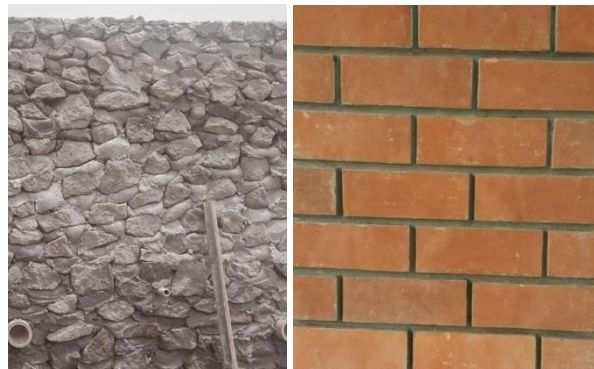
Gambar 5. Material Dinding Batu Kali dan Batu Bata Ekspos
