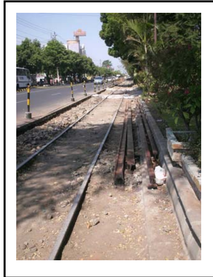
Gambar 1.1. Penggantian Bantalan Rel Kereta Api Di Jl. Slamet Di Riyadi (Sumber: Foto Penulis, 28 - 08 - 2009)
