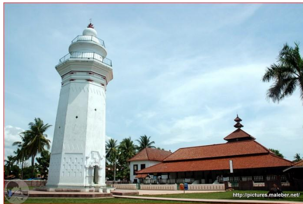
Gambar 2. 5 Menara dengan Tinggi 18m (Sumber : http://abulyatama.ac.id/?p=5964 )
