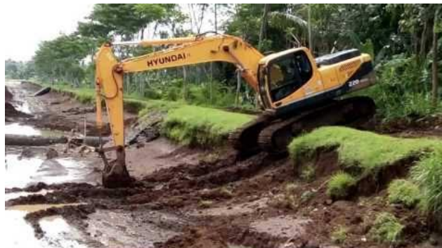
Gambar 4.13 pekerjaan di bidang miring
