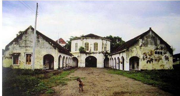
Gambar 1.3.1.7. Bangunan di Dalam Benteng Vastenburg Pra-Demolisi Tahun 90-an (Sumber : situs jejakpiknik.com, diakses 12 Maret 2019)
