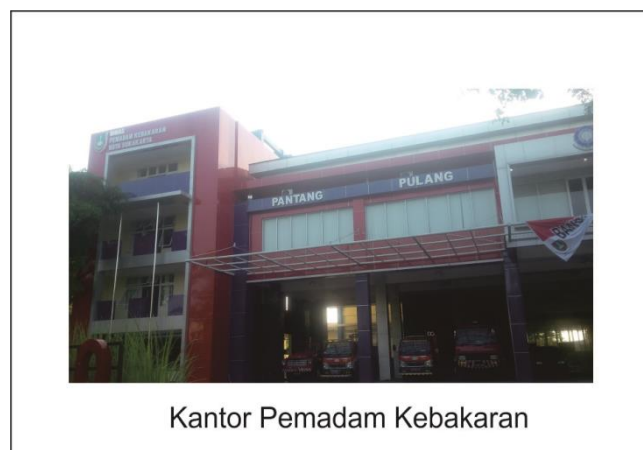
Gambar 9. Kantor Pemadam Kebakaran Berdasarkan Cek Lapangan
