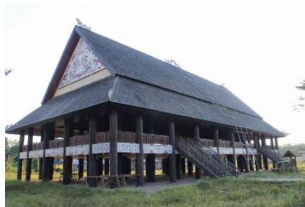
Gambar 18 Rumah Dayak Sumber : https://kalimat.id/rumah-adat-kalimantan-timur/ , 2019
