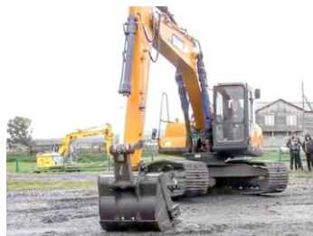
Gambar 14 Gerakan jack swing pada excavator
