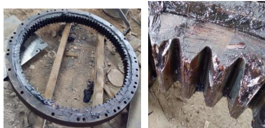
Gambar 19 kerusakan pada Swing circle
