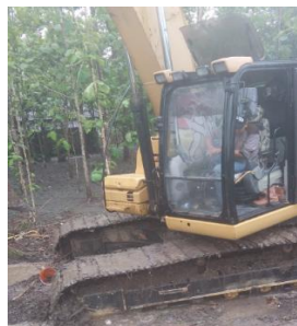
Gambar 1. Uji Coba Kerusakan
