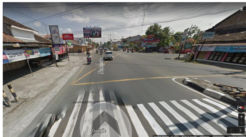
Gambar 4. Kondisi Eksisting STA. 48+300
