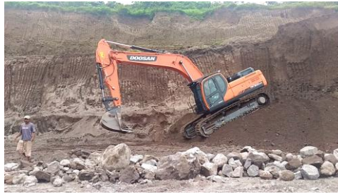
Gambar 23 Kondisi Excavator yang miring.
