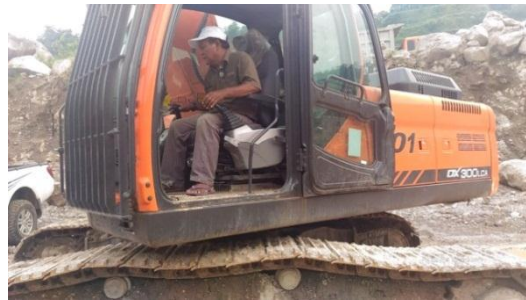
Gambar 8 Uji coba kerusakan.
