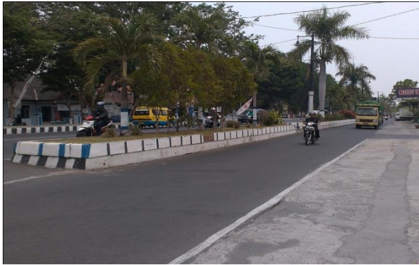
Gambar 1.1 Jalan Lawu Sebelum Dilebarkan tahun 2015
