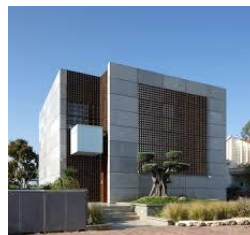
Gambar 3.2 Penerapan expose semen pada tampilan eksterior bangunan
