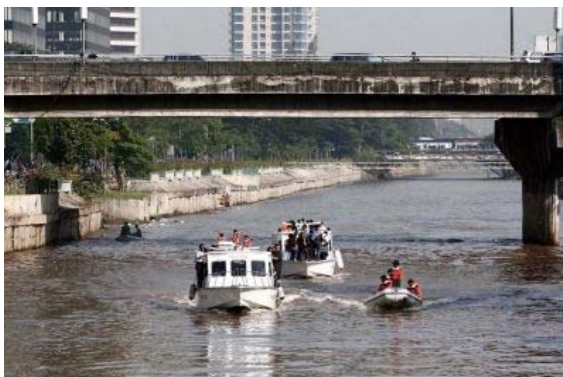
Gb. 6. Sungai Banjir Kanal Barat
