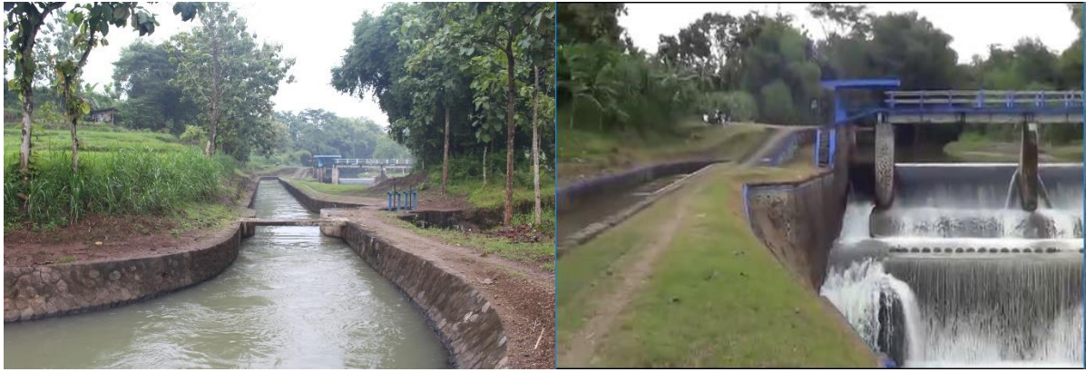
Gambar 2. Bendung Trani Kali Samin/Gembong dan saluran induk ( intake )
