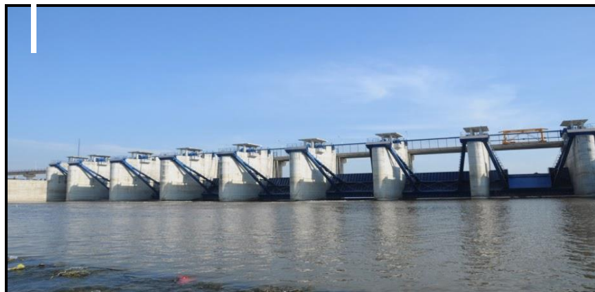
Gambar 1.2 Bendungan gerak di Bojonegoro Sumber : Dokumentasi Pribadi
