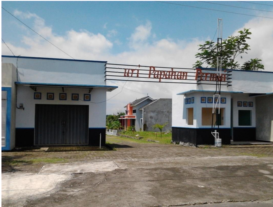
Gambar 1.1. Lahan Permukiman di Desa Papahan Kecamatan Tasikmadu (Februari, 2013)
