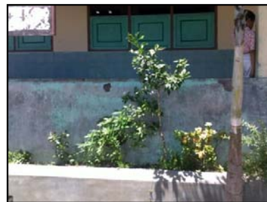
Gambar 6. Pondasi bangunan sekolah dibuat sedikit lebih tinggi
