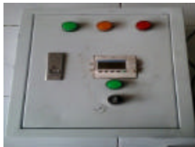
Gambar 9. Pengaman Suhu Tinggi Berbasis PLC terhadap Motor 3 Phase
