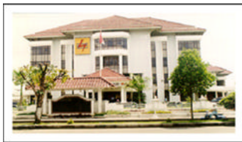
Gambar 1.4 Gedung lama PLN APJ Slamet Riyadi Surakarta Sumber : Panoramio.com
