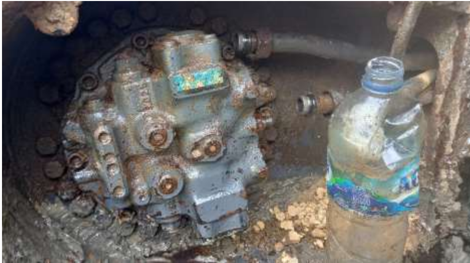
Gambar 18. Motor Case yang Telah Terpasang
