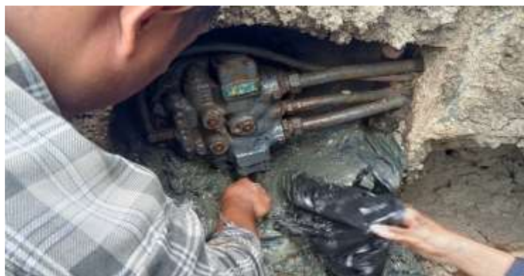
Gambar 1. Proses Pelepasan dan Pembersihan Cover Travel Motor
