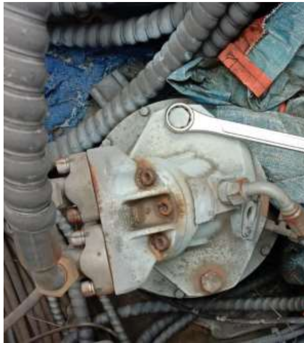
Gambar 6. Melepas baut motor swing
