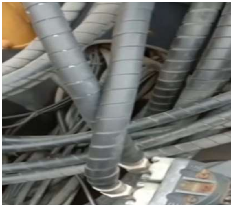
Gambar 1. Pengecekan selang oli hidrolik
