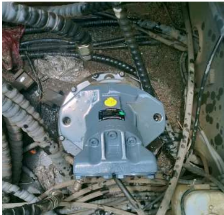
Gambar 8. Meletakkan motor swing baru
