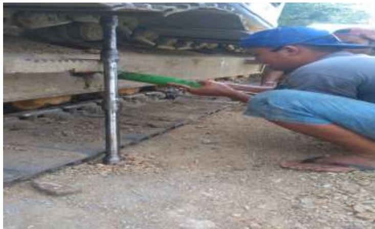
Gambar 23. proses pemberian grease
