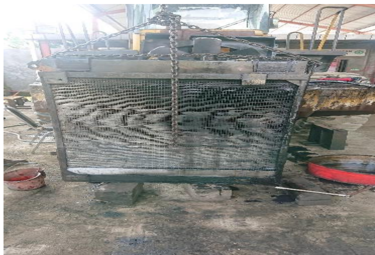
Gambar 6. Pemasangan Katrol Pada Radiator
