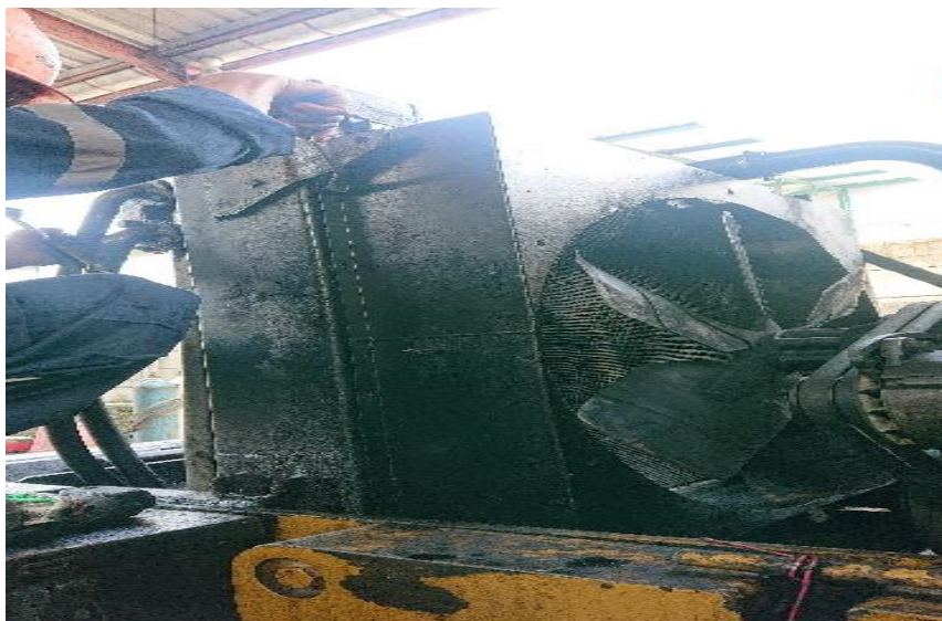
Gambar 12. Pemasangan Cover Kipas Radiator
