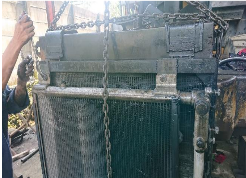
Gambar 7. Pemasangan kembali external radiator
