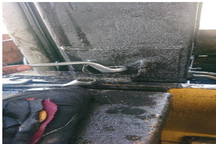
Gambar 3. melepas baut penyangga radiator dengan wheel loader
