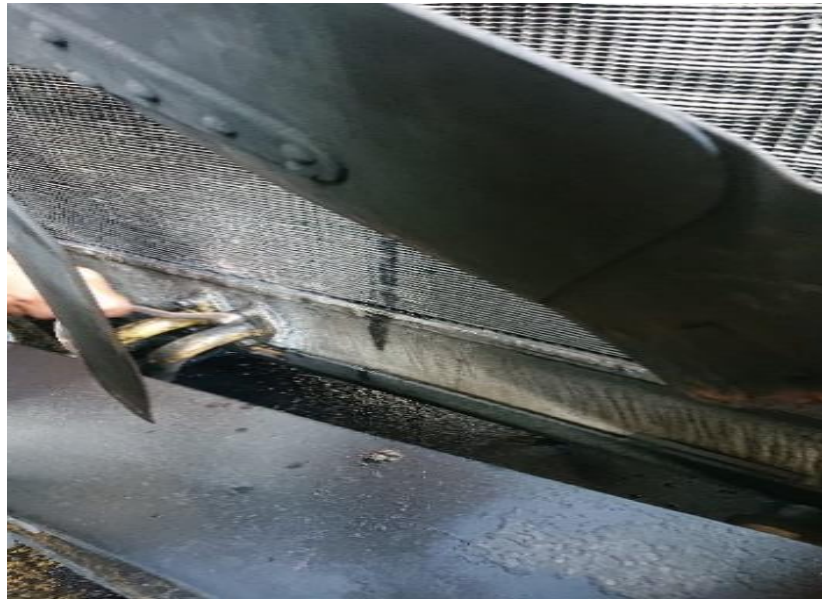
Gambar 9. pemasangan selang bagian bawah
