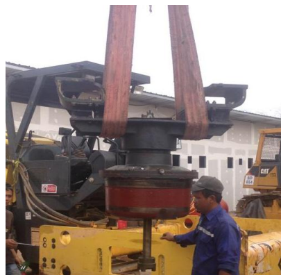
Gambar 4. Pengangkatan drum drive
